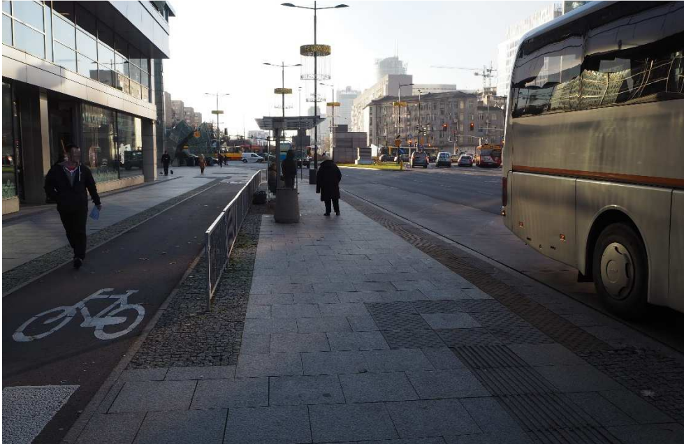
Fot. II.5 Linia prowadząca z polem uwagi, wypustki na linii ostrzegawczej wzdłuż peronu przystankowego Źródło: zasoby VIA VISTULA
