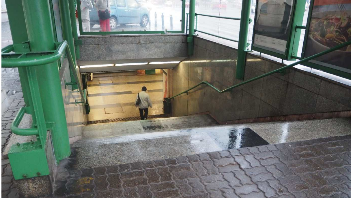
Fot. II.1 Przykładowe zejście do przejścia podziemnego Źródło: zasoby VIA VISTULA
