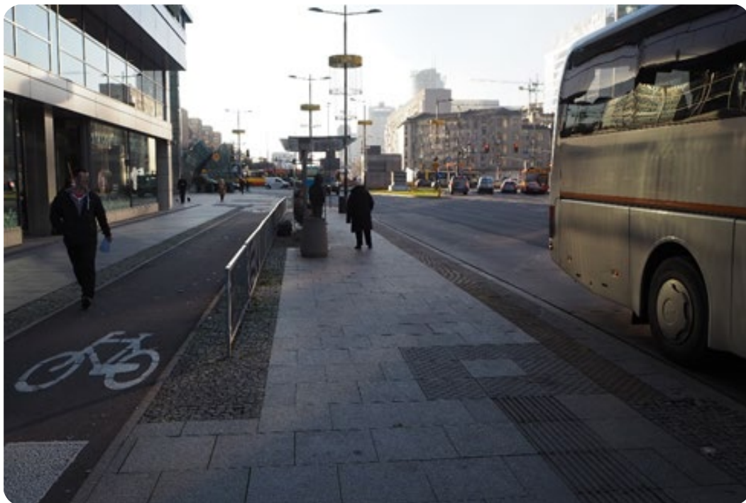
Fotografia II.5. Linia prowadząca z polem uwagi, wypustki na linii ostrzegawczej wzdłuż peronu przystankowego Źródło: zasoby VIA VISTULA
