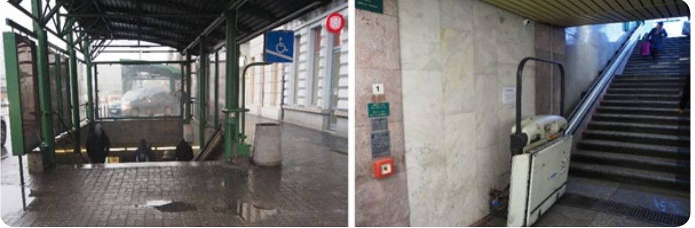
Fotografia II.7. Przykład zastosowanej pochylni mechanicznej Źródło: zasoby VIA VISTULA
