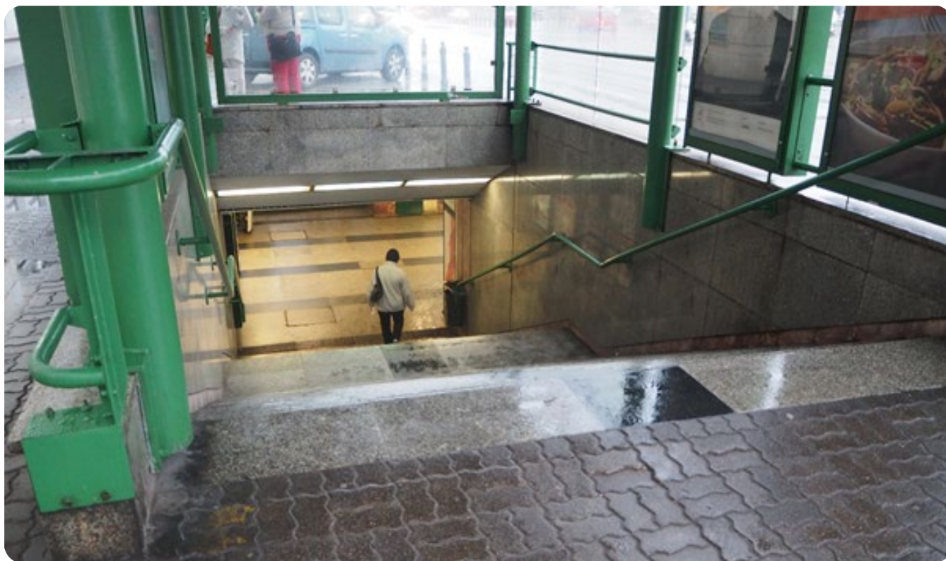
Fotografia II.1. Przykładowe zejście do przejścia podziemnego
