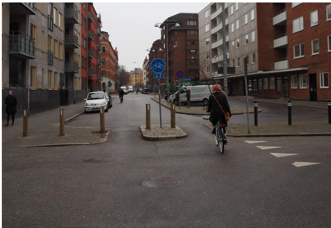
Rysunek 5.10. Przykład rozcięcia ulicy, z dopuszczeniem ruchu rowerów
