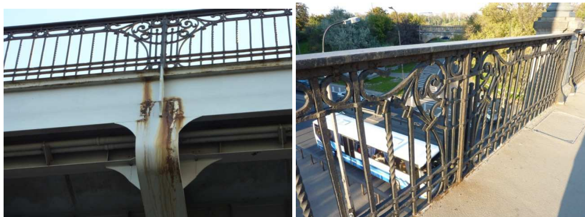
Fot. 9,10. Widok balustrady wiaduktu.
