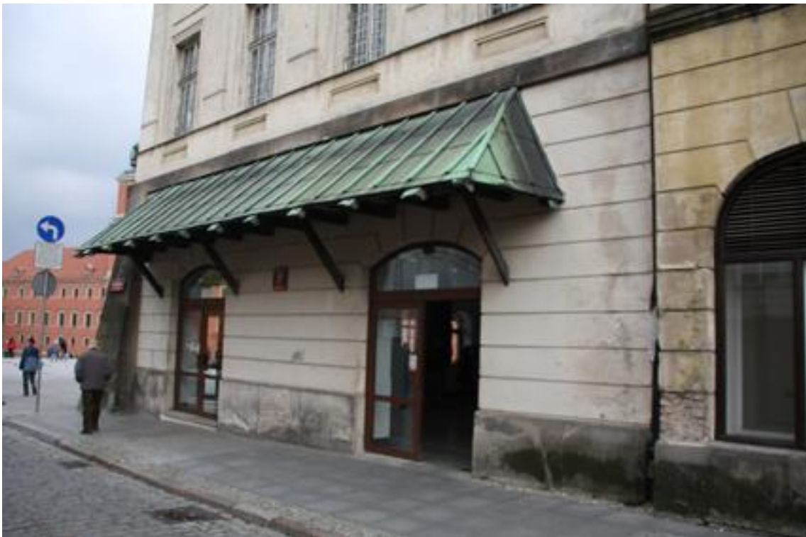
Przyziemie elewacji zachodniej kamienicy Ignacego Nowickiego
