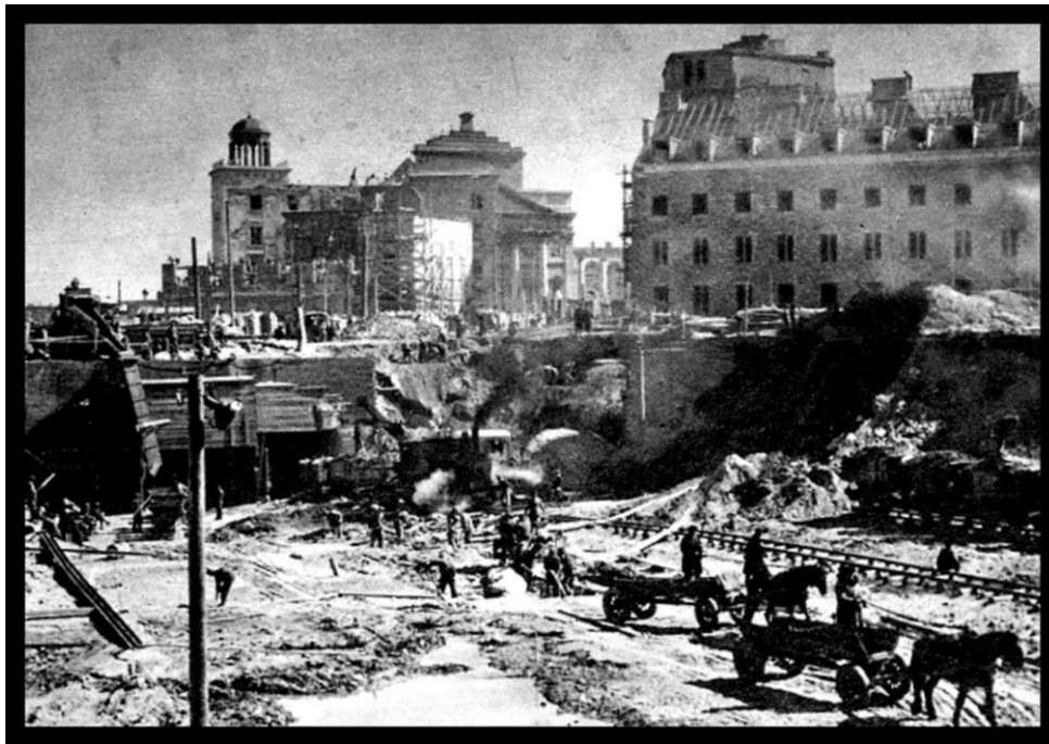
Budowa Trasy WZ z górującą nad nią elewacją zachodnią odbudowywanego pałacu biskupów krakowskich
