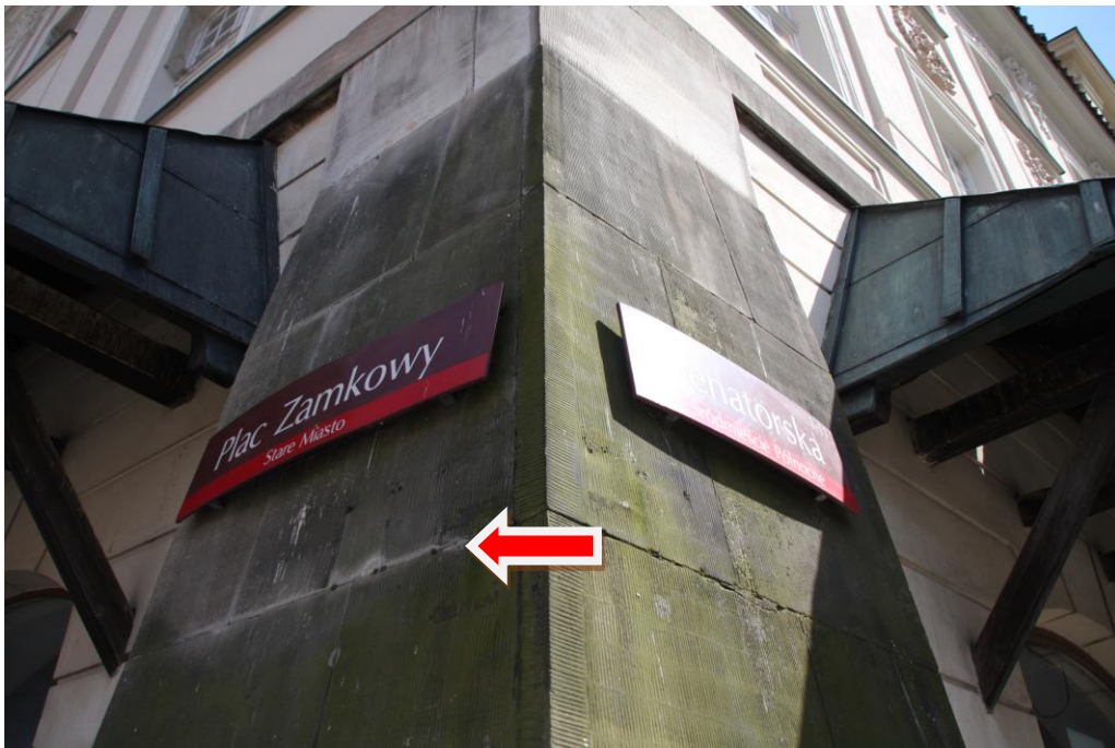
Przypora północno-zachodnia z widocznymi wysoleniami i porażeniem mikrobiologicznym
