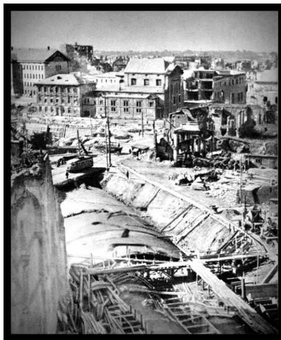
Po lewej stronie fragment ściany kamienicy Prażmowskich oraz sklepienie tunelu Trasy WZ - kamienicy Johna jeszcze nie ma
