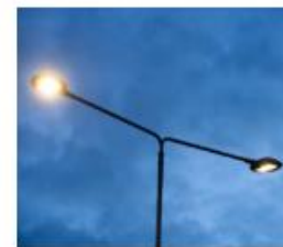
zamontowana nowa oprawa LED
