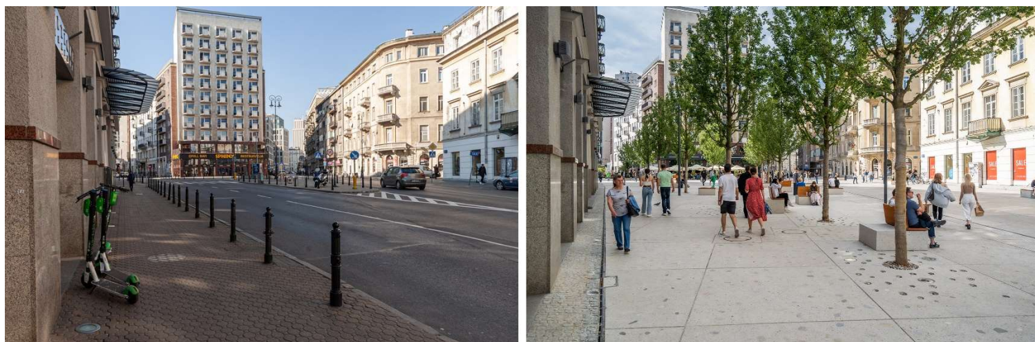
Ilustracja 9. Widok na plac w kierunku ul. Zgoda i Szpitalnej przed i po przebudowie
